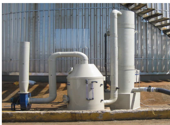
Immagine 15 Impianto pilota per l'abbattimento odori sfiati serbatoi Toscopetrol
