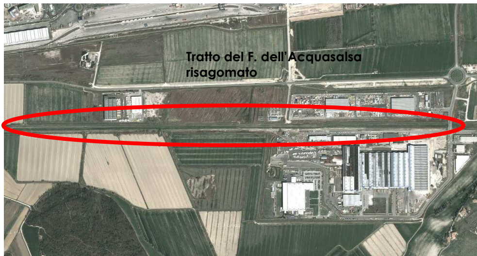
Figura 1 Intervento di risagomatura del Fosso dell'Acqua Salsa
